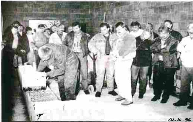
Der **Unipor-Planziegel**: bei der Verarbeitung ist nur noch eine dünne Lagerfugendicke notwendig. Der neue Unipor-Planziegel wird in einer Dünnbett-Mörtelfuge schneller verlegt, die Steine müssen praktisch nur noch aufgeschichtet werden und dies bringt zudem ein Drittel Zeitersparnis gegenüber der Stoßfugenmörtelung. Dabei wird erheblich weniger Mörtel verbraucht, was zu einer deutlichen Senkung der Materialkosten führt.
